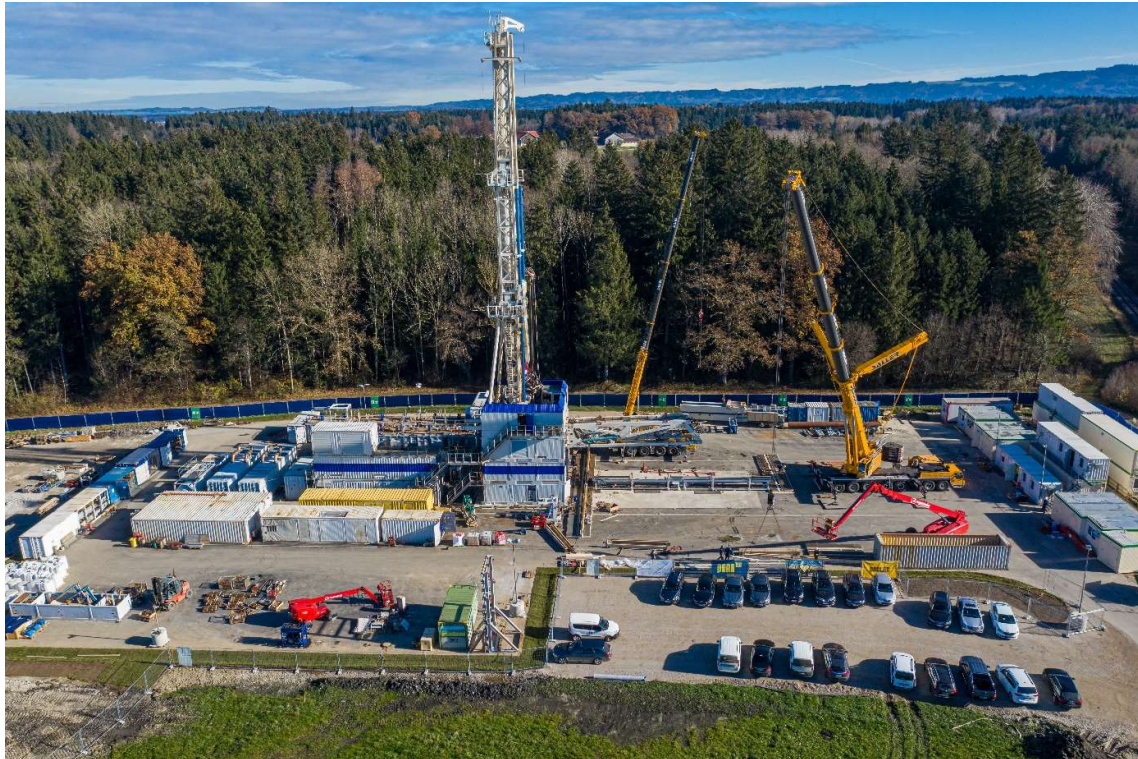
Die erste Bohrung in Kirchanschöring ist gestartet.
