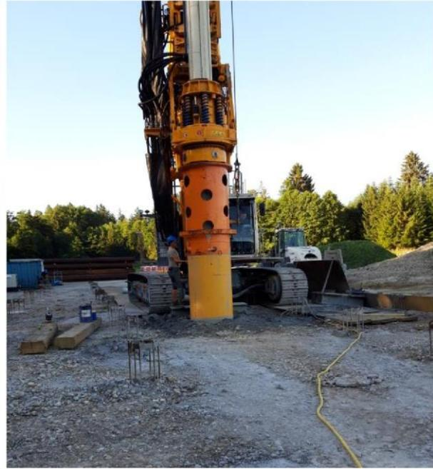
Start Bohrvorgang Schutzrohr
