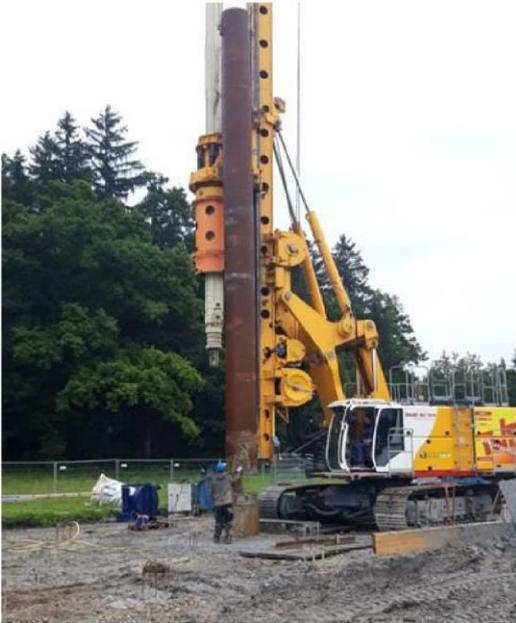
Einbringen der Stahlrohre
