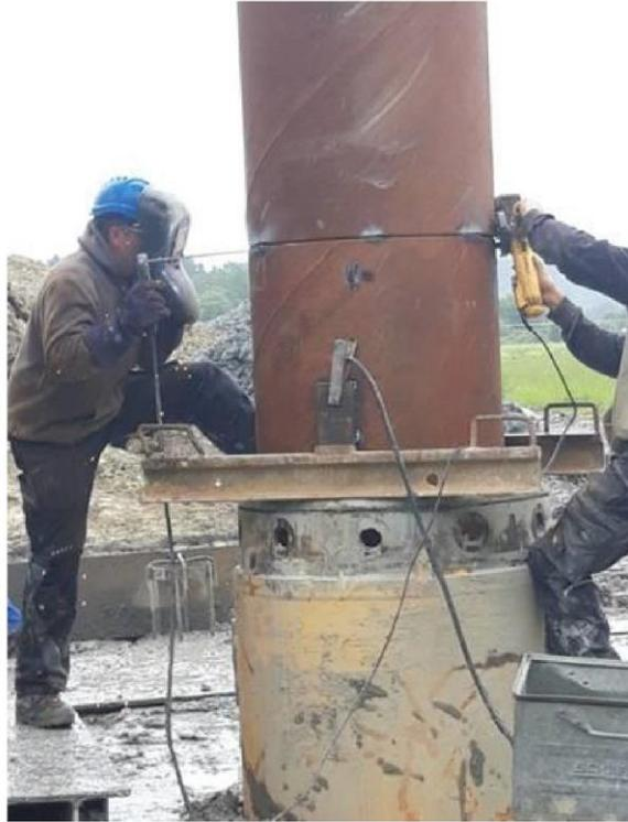
Verschweißen der Stahlrohre
