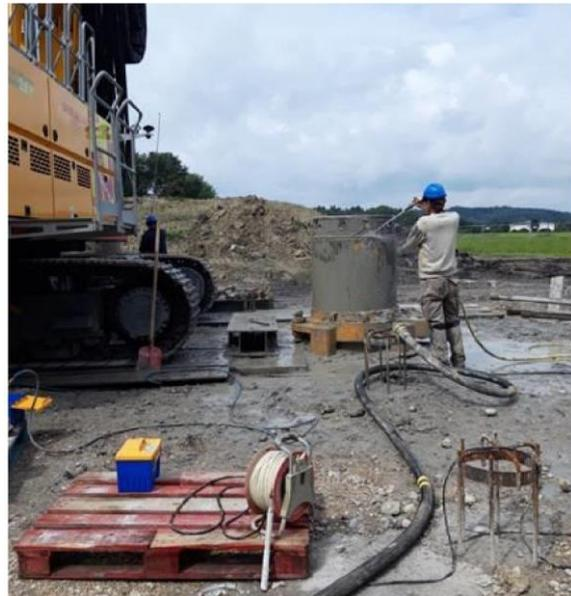
Rohr ziehen und reinigen nach Zementierungsvorgang
