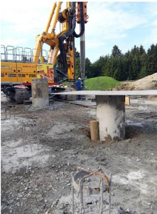
Bohrbetrieb, vorne fertiges Standrohr,
