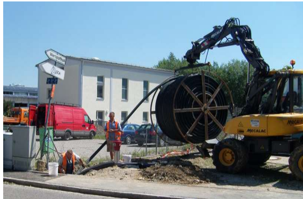
Zeitweise Sperrung von Gehwegen und Straßen für Erdkabel- oder Leitungsbau in Traunreut
