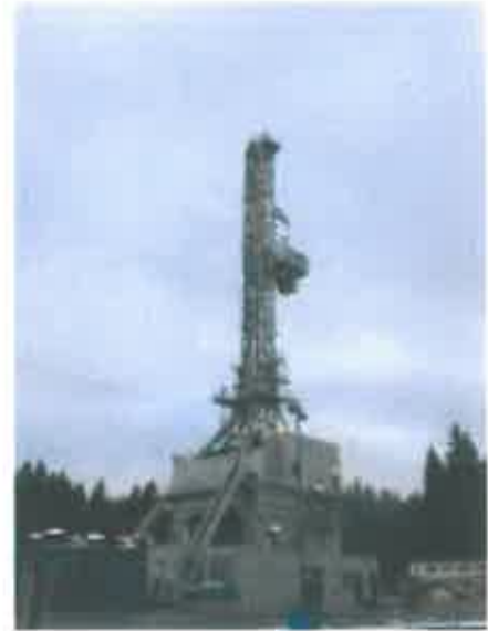
Bohrung Geretsried: nur auf Fazies gebohrt
